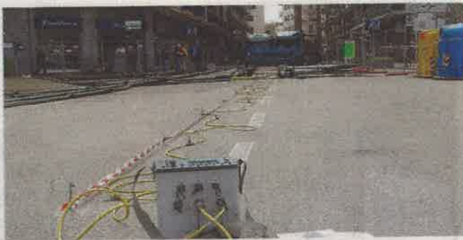
Lavori ancora in corso, 11 mesi dopo l'esplosione delle fogne
