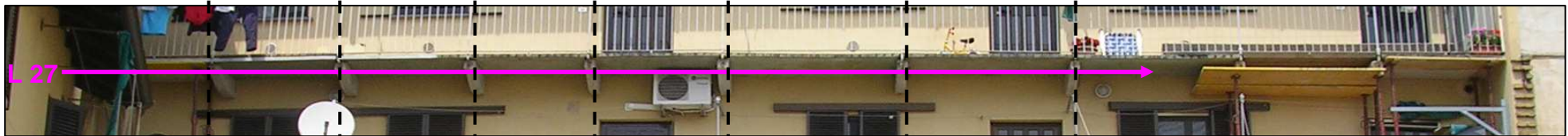
Sezione Georadar L 27: 0.10 m da muro
