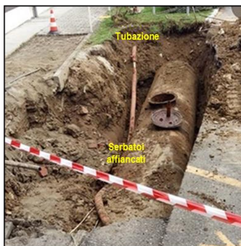
Scavo e scoperta serbatoio
